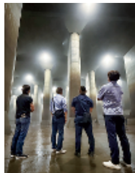
外郭放水路視察。トンネルから流れてきた水の勢いを弱め、スムーズに江戸川に流すための巨大フル。床から天井まで18m、奥行きは177mある。
