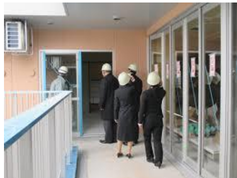
建設現場見学会
